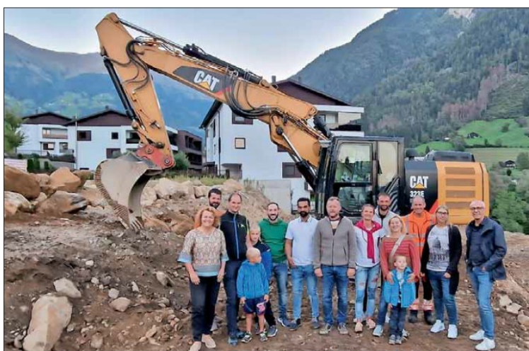
Baubeginn in der Wohnbauzone Haslach in St. Martin: Gruppenbild mit Mitgliedern der Wohnbaugenossenschaft Haslach sowie Bürgermeisterin Rosmarie Pamer (links), Vizebürgermeister Erich Kofler (Dritter rechts) und Architekt Manuel Benedikter (rechts). Gemeinde
