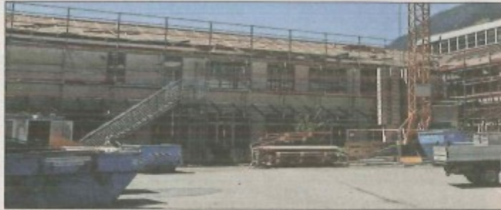
Die Mittelschule St. Martin wird energetisch saniert.
